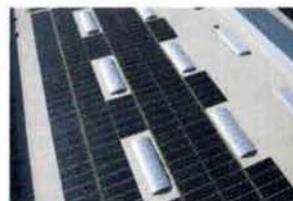
Le bâtiment est écologique. 55% de ses besoins en énergie sont couverts grâce à une toiture équipée de 22 000 m<sup>2</sup> de panneaux photovoltaïques.
